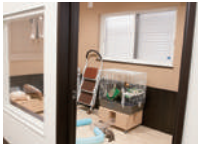
牆面裝有踢腳板，便於清除髒污。▲
